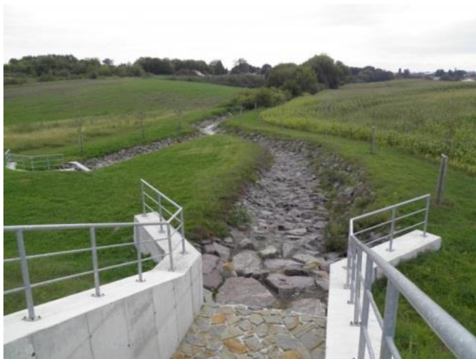
Protipovodňová opatření v katastrálním území Prušánky po provedení úpravy
