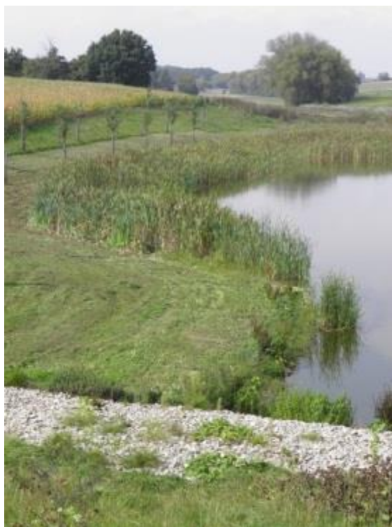
Protipovodňová opatření v katastrálním území Prušánky po provedení úpravy
