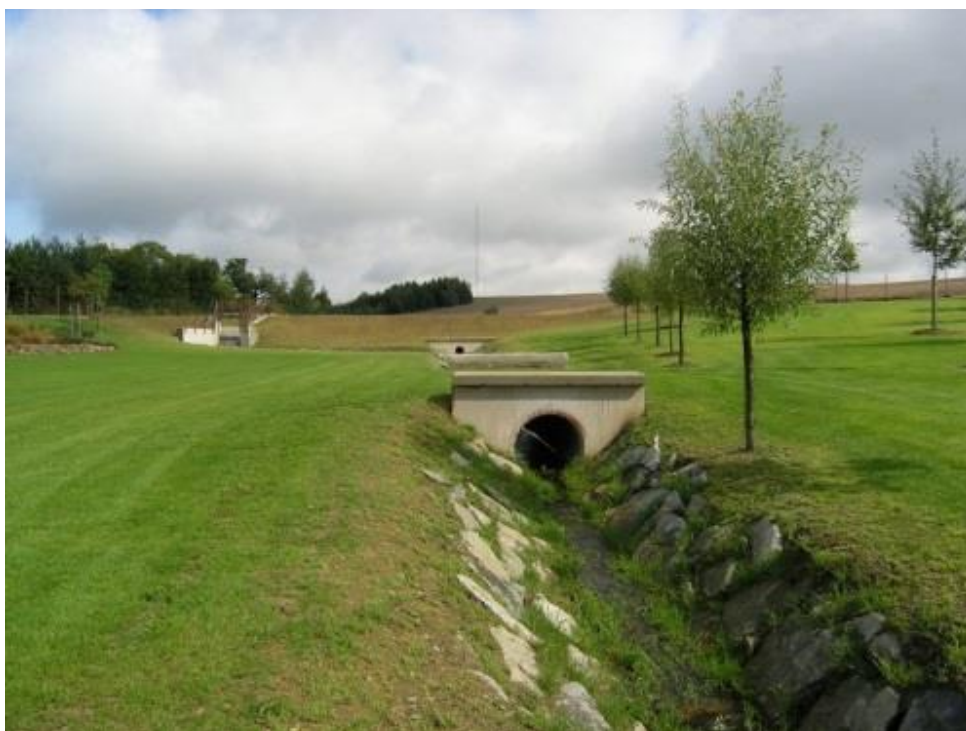
Suchá retenční nádrž v katastrálním území Senetářov po provedení úpravy
